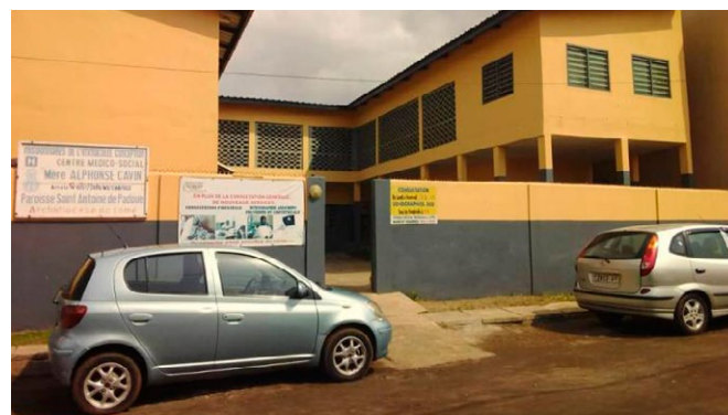
CMS de Lomé, con paredes reparadas y nuevos aparatos médicos.
