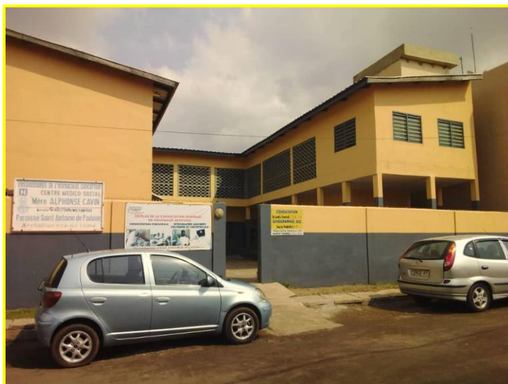
Nuevo aspecto del CMS de Lomé, Togo, con las paredes reparadas y pintadas, y con nuevos aparatos médicos instalados.
