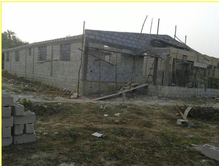
La Peace Clinic y orfanato Sister Chantal de Monrovia, en construcción.
