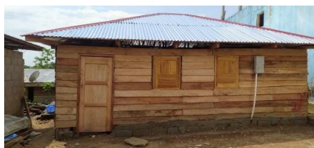
Rehabilitación de vivienda tras la explosión.
