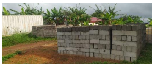
Construcción de bloques para rehabilitar viviendas
