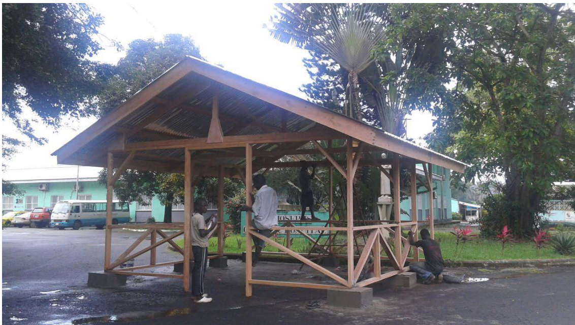
Construcción triaje y CCC
